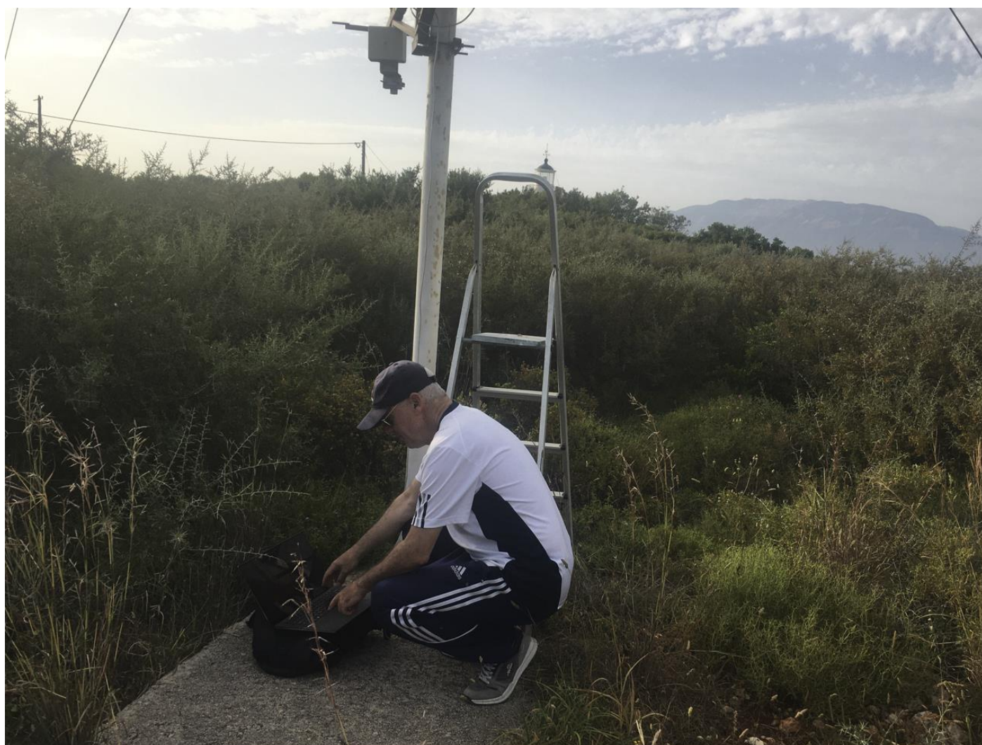
Εικόνα 1.2-3: Απο τις τεχνικές εργασίες στον σταθμό ΖΚΤ-3 στις 30/5/2022.
