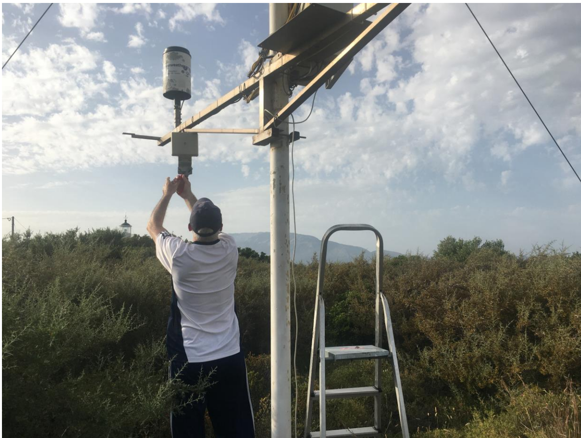
Εικόνα 1.2-4: Απο τις τεχνικές εργασίες στον σταθμό ΖΚΤ-3 στις 30/5/2022.
