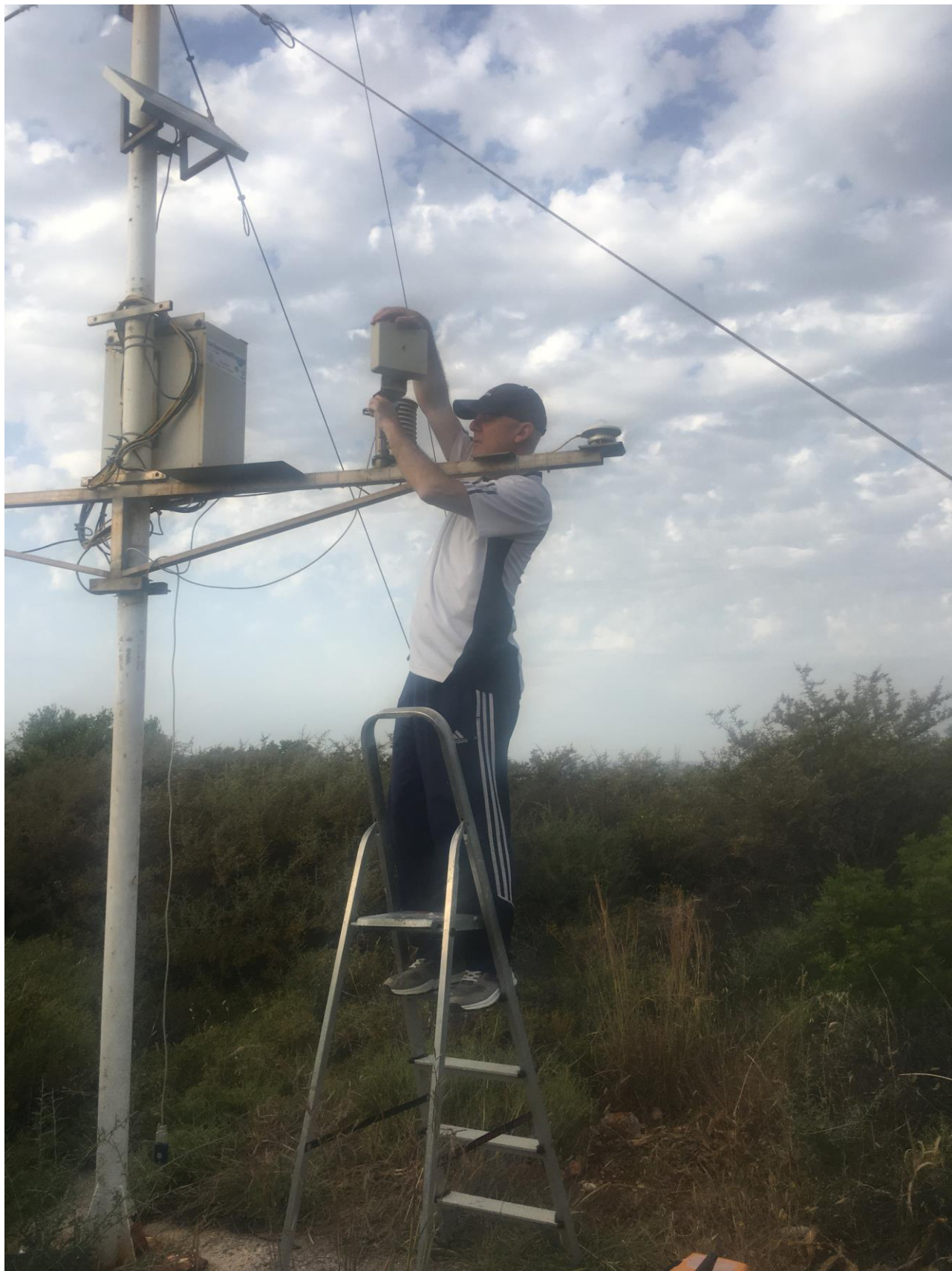
Εικόνα 1.2-4: Απο τις τεχνικές εργασίες στον σταθμό ΖΚΤ-3 στις 30/5/2022 (μετεγκατάσταση κατευθυντικής κεραίας GSM).
